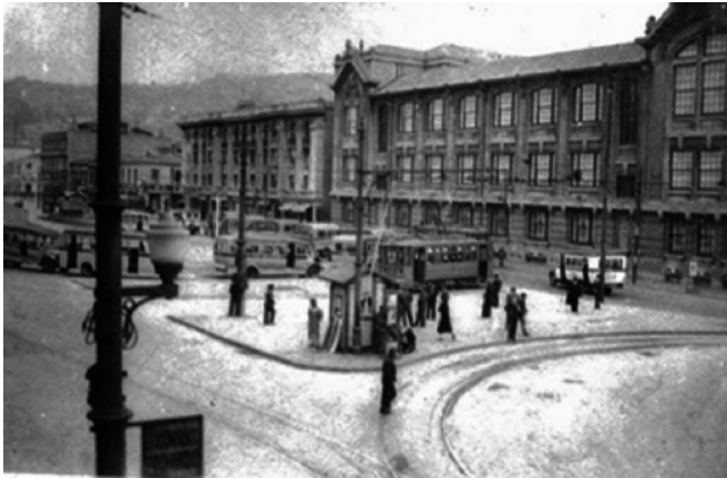
Figura N° 3 Avenida Argentina, Casa Central PUCV.
